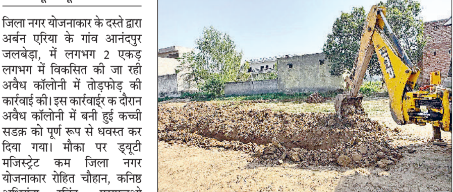
अंबाला। अवैध कॉलोनी में हुए निर्माण को ध्वस्त करती जेसीबी।
